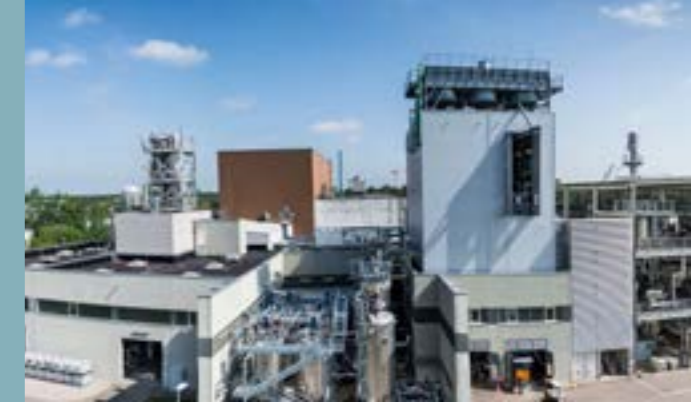
Die Pilotanlage verbindet alle Stufen des bioliq®-Prozesses: Schnellpyrolyse, Hochdruck-Flugstromvergasung, Heißgasreinigung und Synthese. Foto: KIT
